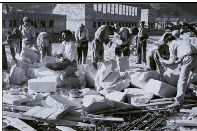
Radovi na izgradnji nekadašnjeg Đačkog doma "Dule Mučibabić" u Mostaru. Slikano 15. 9. 1947. Izvor: CIDOM.
