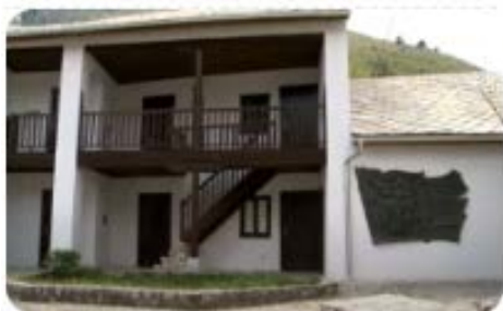
Renovirana Muzej-kuća Vukovića u Donjoj mahali u Mostaru
